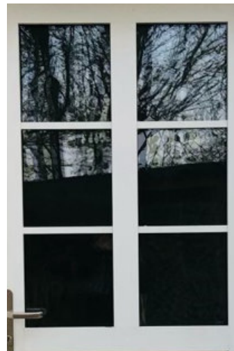
aufgeklebte Sprossen mit Abstandshalter im Scheiben- zwischenraum
